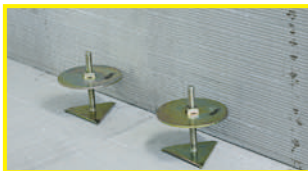
1º Posicionar niveladores.
