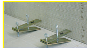
1º Posicionar niveladores.
